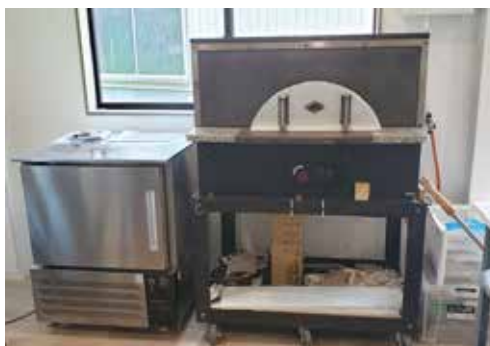
建物1階(ピザ窯と冷凍庫)
